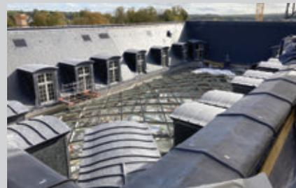
▲ Une verrière autostable de 600 m<sup>2</sup>, constituée de profils d'acier et de vitrages cintrés et prenant appui sur les murs au ras des toitures à 11 m de hauteur, coiffe la cour du jeu de paume.
