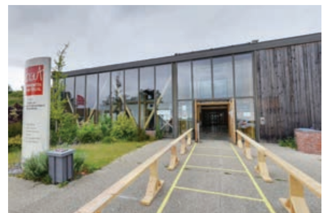
Le CFP Sainte-Barbe des Apprentis d'Auteuil dispose d'un large plateau technique dédié à la formation aux métiers du Bâtiment.
