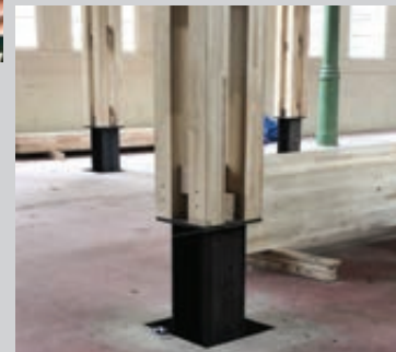
▲ Des pieux ont été insérés sur le sol existant pour porter la structure bois.
