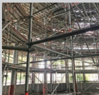
▲ L'échafaudage complexe mis en place pour restaurer la serre.
