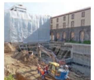
Les façades sont restaurées et un "parapluie" sera posé pour remplacer la toiture et la couverture.
