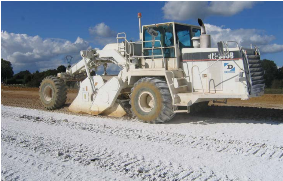
▲ Figure 23 – Plateforme traitée à la chaux (@Olivier Dannau)
