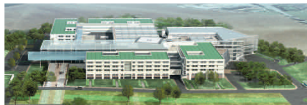
Le secteur hospitalier s'affiche comme un pôle de développement pour Pertuy Construction, filiale de Bouygues.
