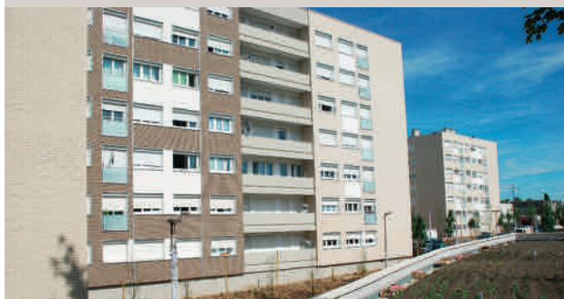
▼ Rénovation des façades avec des panneaux préassemblés, constitués d'un parement en terre cuite intégré à un panneau isolant en polyuréthane.
