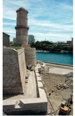
Le fort Saint-Jean, en cours de rénovation à Marseille.
