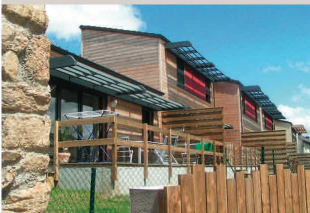
▲ Un vieux mur conservé, un dénivelé atypique et des maisons différenciées, tout a été étudié pour éviter l'effet répétitif de l'ensemble.
