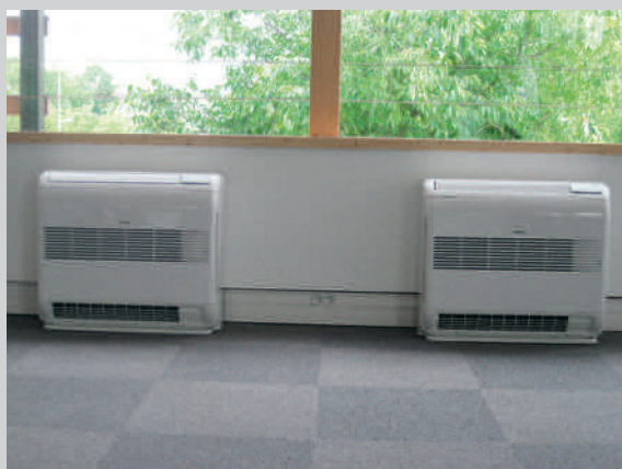
▲ ▲ Le rez-de-chaussée bénéficie de 2 groupes SMMSi 2-tubes taille 6 CV et de 18 consoles compactes double flux réparties dans les différents bureaux.
