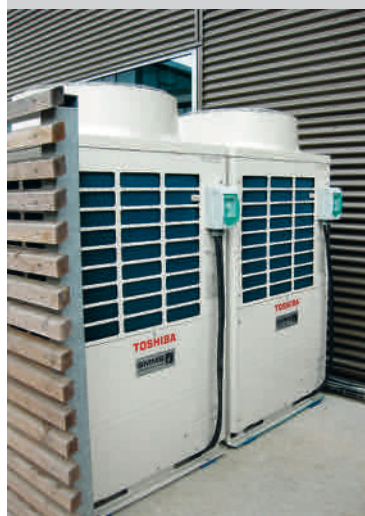
▲ ▲ Le rez-de-chaussée bénéficie de 2 groupes SMMSi 2-tubes taille 6 CV et de 18 consoles compactes double flux réparties dans les différents bureaux.
