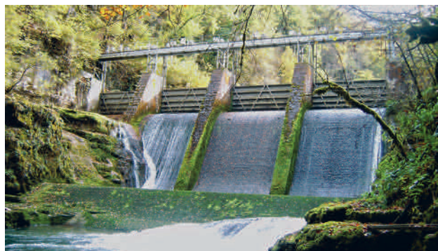
Un exemple de centrale hydraulique, à la source de la Loue en Franche-Comté).
