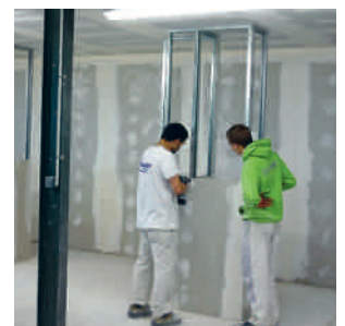
L'atelier de plâtrerie a été aménagé selon les normes actuelles.
