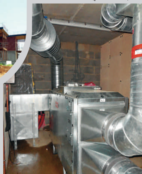
▼ Le système double flux KWL EC 1800 S Pro WW d'Helios Ventilateurs est une centrale compacte équipée d'un échangeur en alu à contre-courant à très haute efficacité (plus de 82 %).
