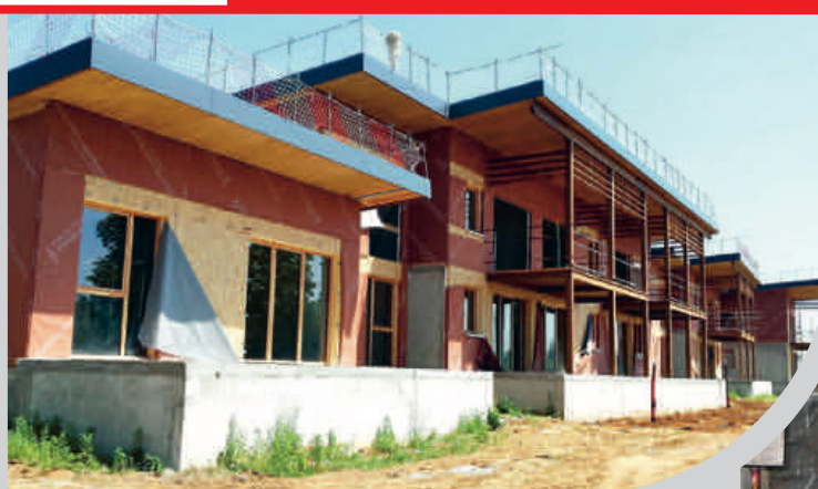
▲ Pour éviter la mise en place d'un rafraîchissement, les ouvrants en façade sud ont été équipés de dispositifs de protection solaire.
