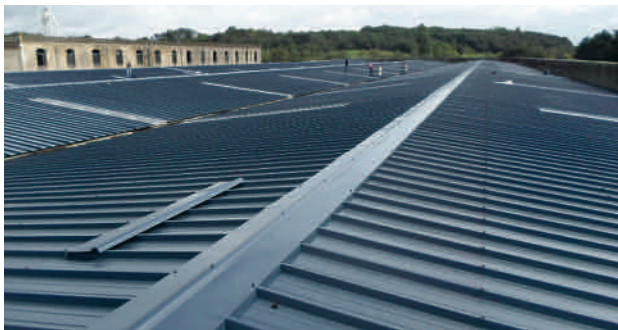
Les travaux sur la toiture de l'entreprise Papault ont démarré.
