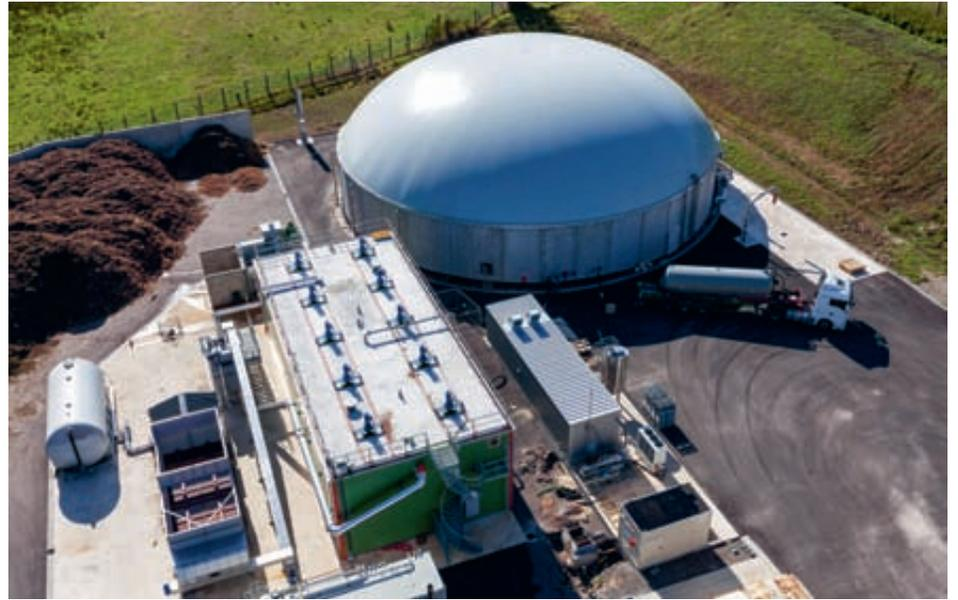
coles qui sont sollicités pour préparer la matière broyée nécessaire au processus de méthanisation. Mise en service en décembre dernier, Méthavos I est alimentée par 20 000 tonnes d'intrants "franco-allemands" pour produire l'équivalent de 10 000 mégawattheures (MWh) sous forme de biogaz liquide par an, mais également des sous-produits : 6 000 m<sup>3</sup> de digestats (engrais agricole) et 5 000 tonnes de compost. À l'arrivée, le dispositif de Sarre-
