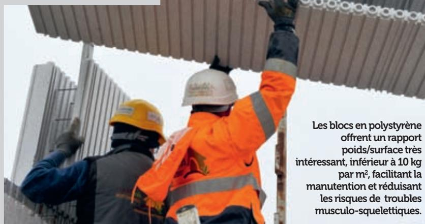
Les blocs en polystyrène offrent un rapport poids/surface très intéressant, inférieur à 10 kg par m<sup>2</sup>, facilitant la manutention et réduisant les risques de troubles musculo-squelettiques.
