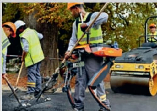
UN PROTOTYPE D'EXOSQUELETTE réalisé avec RB3D, est expérimenté à Genève et pourrait être généralisé dès 2017 auprès des collaborateurs de la filiale suisse du groupe Colas travaillant sur les routes. au lissage du bitume.
