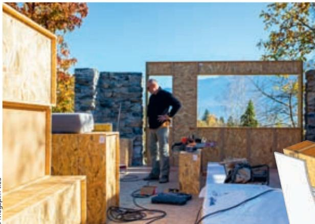
L'isolant (laine de verre, de bois ou de roche au choix) ne risque pas de se tasser. Encapsulé dans un caisson composite en bois, il n'est pas en contact avec l'extérieur. La manipulation est plus agréable, et il n'est pas possible aux nuisibles de détériorer l'isolant.
