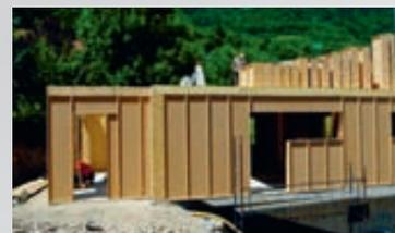
7 **Blokiwood®** : système constructif innovant et breveté de murs porteurs en bois ultraperformants qui permet de réaliser des murs de structure intégrant l'isolation et l'étanchéité à l'air en une seule opération.
