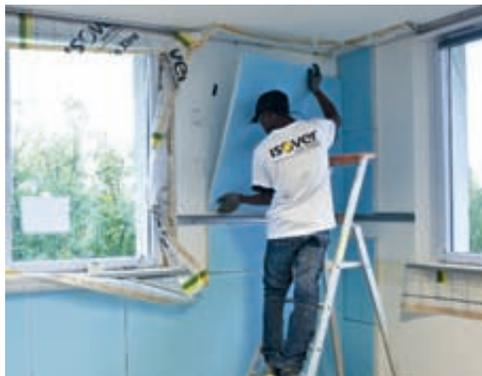
En 50 mm d'épaisseur (+6 mm d'XPS), on obtient un R de 8 m<sup>2</sup>.k/W. Avantage déterminant pour les chantiers en ITI qui demandent souvent de limiter considérablement la perte en m<sup>2</sup> habitables.
