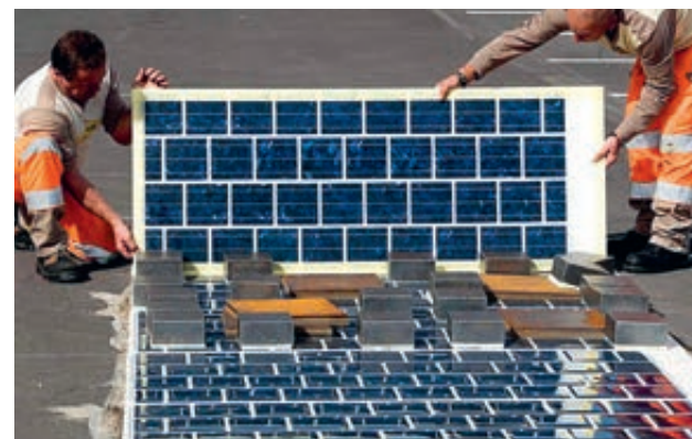
D'ici à 2022, le gouvernement veut déployer plus de 1 000 km de routes solaires en France.
