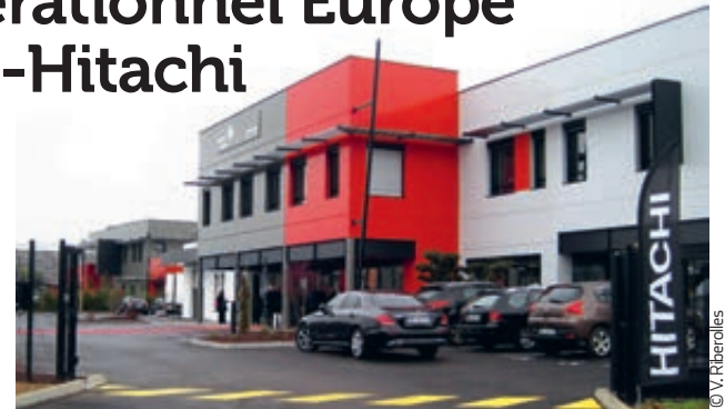
Sur 1 500 m 2 de surface, les nouveaux locaux hébergent en particulier l'un des deux centres nationaux de formation, avec celui de Toulouse. Il accueillera près de 500 clients et techniciens chaque année.
