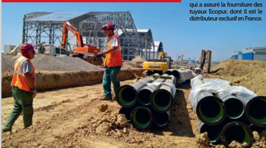
▼ Ce tuyau, disponible en longueur de 6 mètres, est adapté à la réalisation de réseaux de transport et de distribution d'eau potable labellisés ACS. Sa résistance chimique PH varie de 1 à 14.
