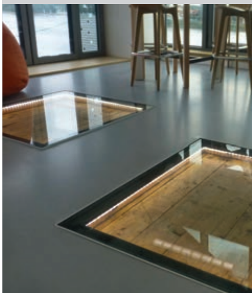
▲ Clin d'œil au passé industriel, ces morceaux de plancher, qui portent les traces de dessins à l'échelle 1 des coques de bateaux, ont été encapsulés et déclinés en "fenêtres de sol".
