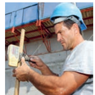
Un maçon de Chambon vérifie le niveau du béton.
