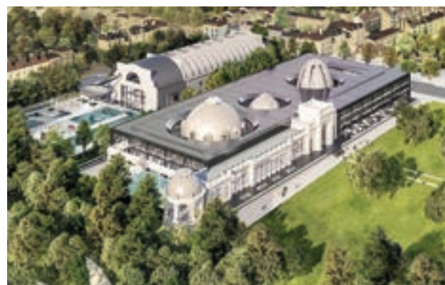
Le projet Grand Nancy Thermal utilisera l'eau thermique naturelle comme une partie de sources d'énergie du complexe.
