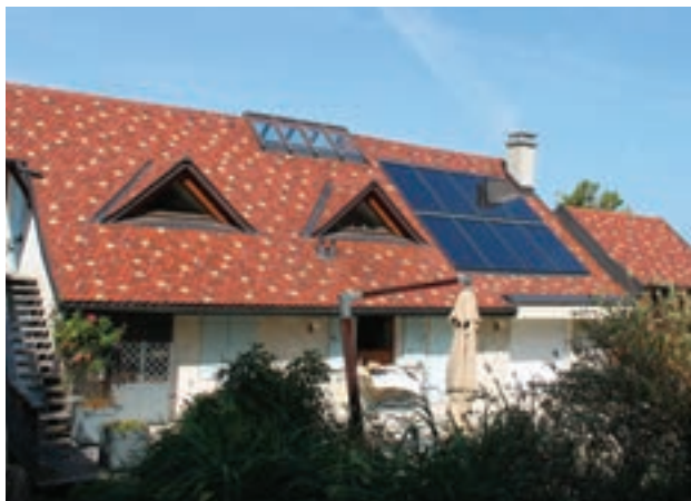
Capteurs plans vitrés intégrés. Le panneau solaire thermique permet d'économiser jusqu'à 4 fois plus d'énergie par m 2 de capteur par an qu'un panneau solaire photovoltaïque.
