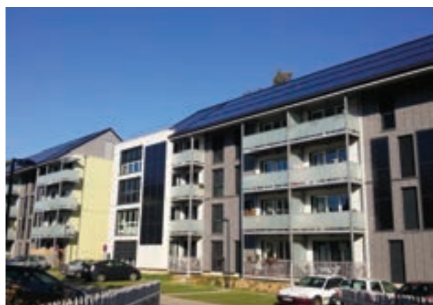
Les 3 immeubles de 40 logements Bepos "Presqu'île", à Malaunay (76), ont été livrés en 2015. Ils sont fournis en ECS et chauffage par 2 x 120 m 2 de capteurs plans intégrés en toiture et 60 m 2 sur châssis, mutualisés par groupes de 8 logements (conso chauffage + ECS : 22 kWh/m 2 .an).
