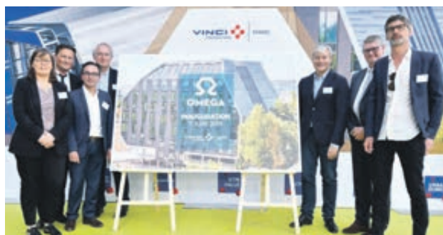
Les différents acteurs du programme tertiaire Omega, réalisé par Vinci Construction, ont inauguré le bâtiment le 7 juin dernier.
