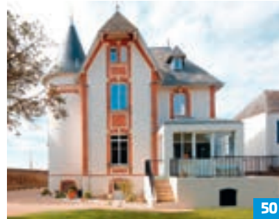
Une villa Belle Époque rhabillée
