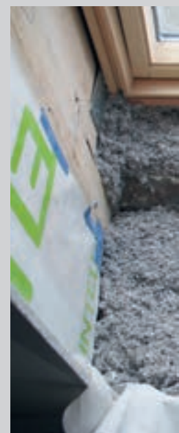
Les panneaux de laine de bois sont découpés pour isoler les murs.
