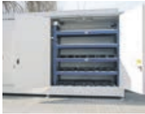
Local de contrôle et de recharge pour batteries lithium-ion.
