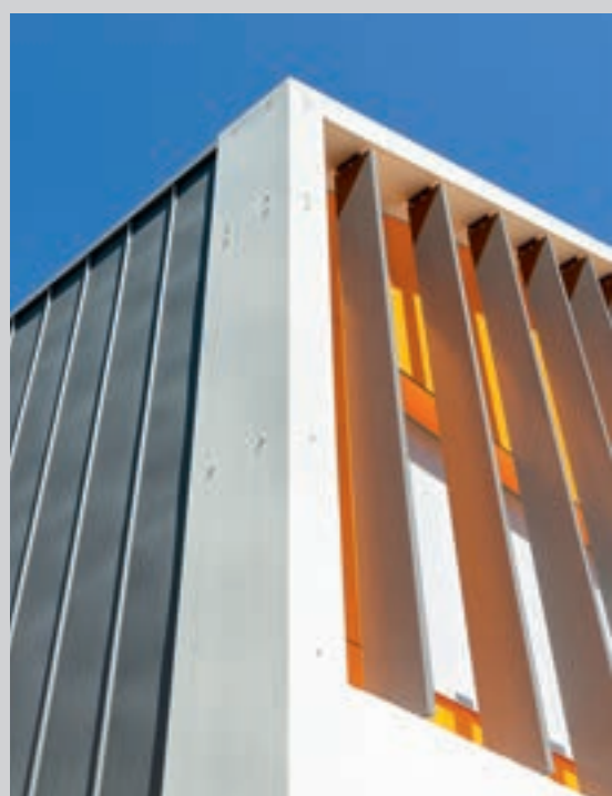
▲ Gros plan sur le joint angulaire ArtColor Skygrey
