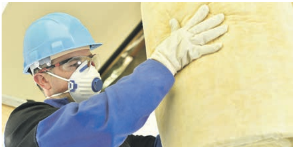
Outre la pose dans les règles de l'art de l'isolant, bientôt renforcée par 2 DTU, la certification Acermi est garante du niveau de performance du matériau, pour un confort d'usage pérenne.
