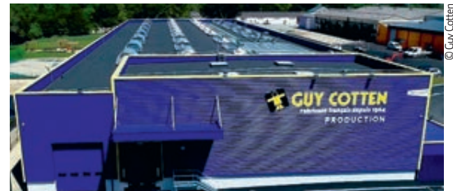
Isolation thermique et phonique renforcée, éclairage optimisé, photovoltaïque pour faire fonctionner en partie les lignes de production... Les 4 500 m 2 de la nouvelle usine de Guy Cotten se veulent vertueux.
