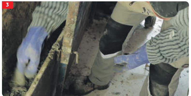
**3 RÉPARTITION DU MORTIER.** On appuie avec la main munie d'un gant en insistant près des liteaux et dans les angles. La pression doit rester faible pour bien répartir le mélange sans le tasser, car il faut enfermer de l'air dedans pour conserver un pouvoir isolant et assurer la résistance thermique. La banche peut ensuite être enlevée et repositionnée en recouvrant de 10 cm le mélange déjà posé.
