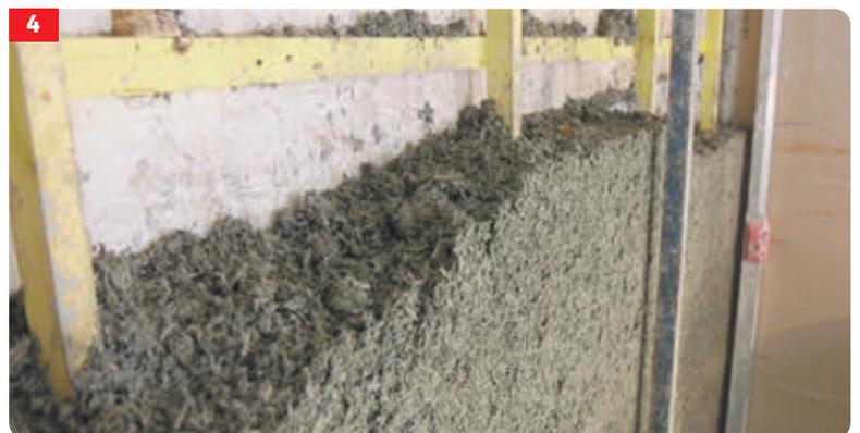
**4 DÉBANCHAGE ET SÉCHAGE.** Il faut compter plus de 3 mois pour un séchage à cœur, et maintenir la pièce hors gel en assurant une ventilation. À savoir : le chanvre est minéralisé par le liant et présente un double intérêt : il ne pourrit pas et supporte mieux les variations d'humidité qu'une laine. Les résistances thermiques vont dépendre des couples liant-chanvre validés.
