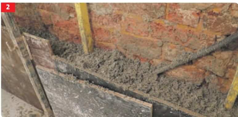
**2 MÉLANGE ET MISE EN ŒUVRE.** Le dosage est réalisé en fonction des préconisations des fabricants selon les règles professionnelles établies. Le mélange est déversé puis réparti sur une hauteur de 10 cm environ.
