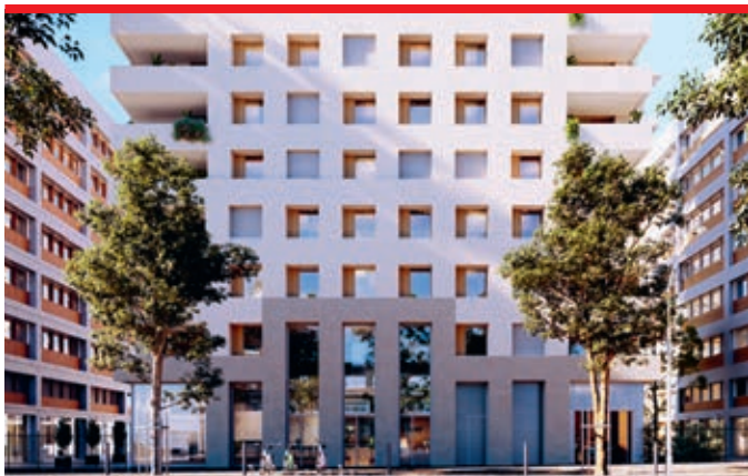
▼ Le concept 2226 a séduit en dehors des frontières autrichiennes et s'est retrouvé dupliqué à Emmen (Suisse) avec ce bâtiment compact aux apports solaires contrôlés.
