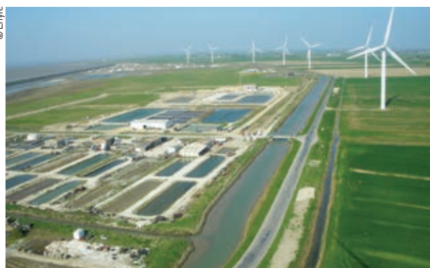
Bouin accueille le premier site au monde de production d'hydrogène renouvelable à partir d'énergie éolienne.
