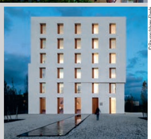
Le pionnier des constructions passives 2226, conçu par les architectes autrichiens dès le début des années 2010. ►
